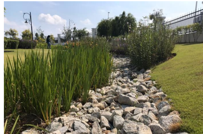
Swales + WQ Drainage
