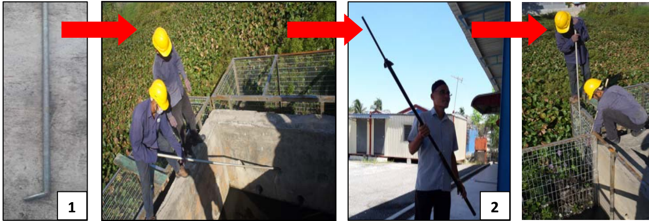
Gambar 1: Proses pelaksanaan ujicuba 1 alat/ kaedah selenggara Pagar Penahan Kelodak
